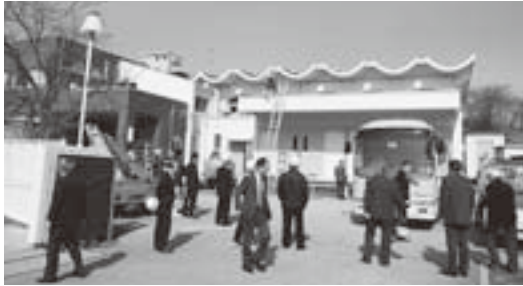
中学校給食実施に向け 増改築中の給食センター
