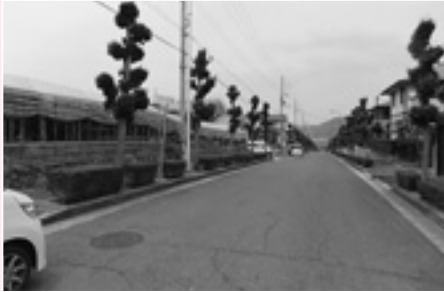
路面にひび割れが目立つ 西山竜王子線の路面舗装整備
