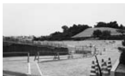
9月20日オープンに向けて工事進行中
