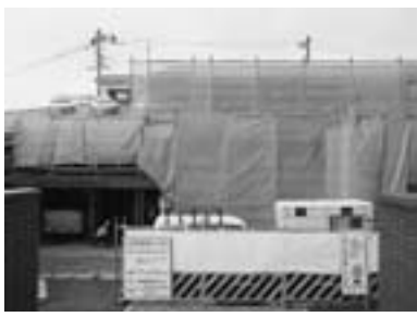
地域活性化の拠点 工事中の自休村センター
