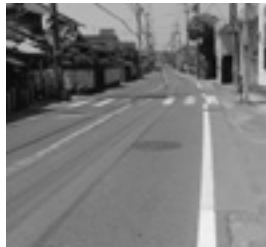
設置された区画線
