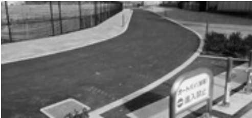
太井川3号線整備
