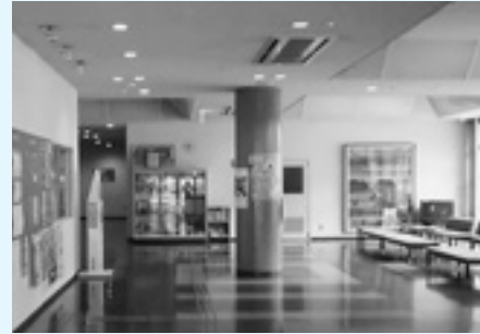
▲総合体育館エントランス空調機更新
