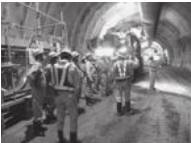
▶トンネル工事の工法の説明を受けました
