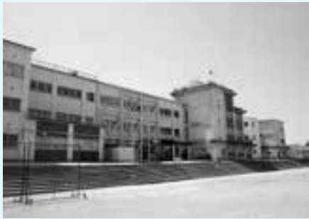
▲町立中学校屋上防水・受水槽改修
