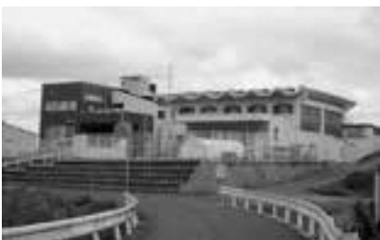
給食センターの改修
