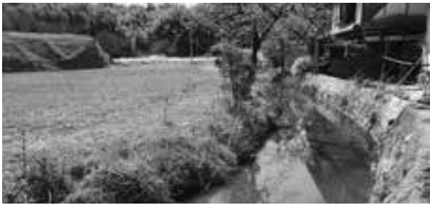
太井川の未改修部分を整備
