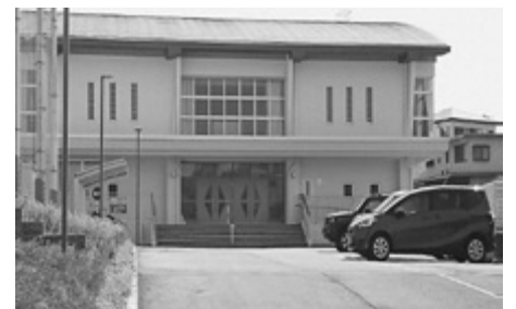
山田小学校体育館防災倉庫
