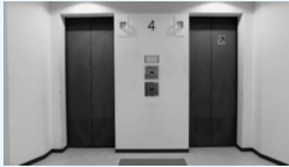
庁舎エレベーター更新
