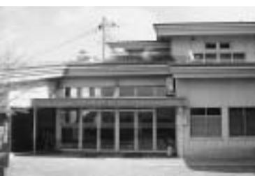
老朽化が進む自然休養村管理センター
