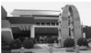
役場庁舎の大屋根に太陽光システムは？
