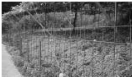
防護柵の設置
