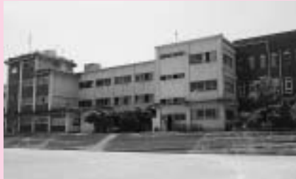
中学校耐震工事が始まります
