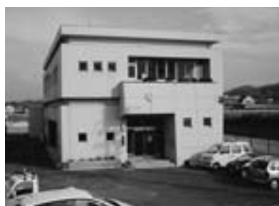
▶板屋橋浄水場
