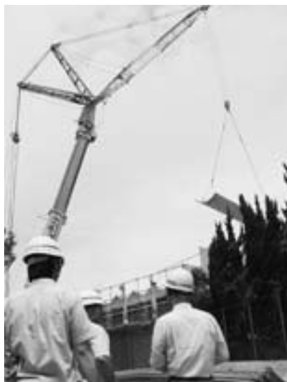
巨大なクレーンに吊り上げられる屋根部分
