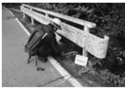
橋梁の老朽化調査
