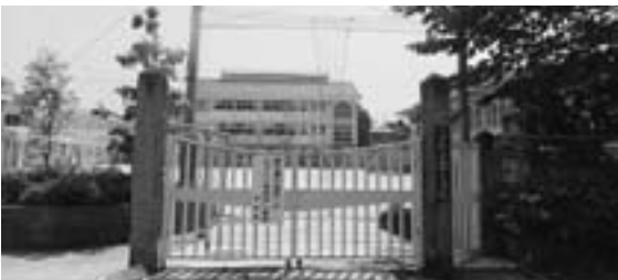
山田小体育館改築工事が始まります
