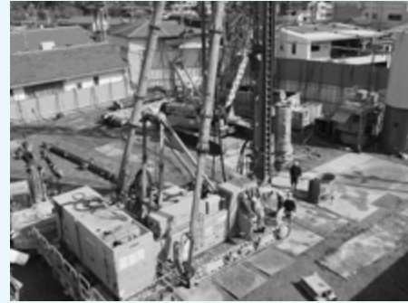
▲生涯学習施設建設へ進む工事
