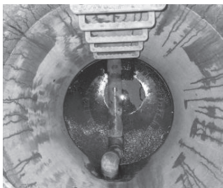
下水のマンホール内
