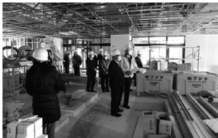
床も天井もこれからの現場 (2月21日)
