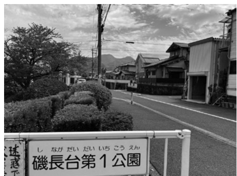
磯長台が開発（昭和49年3月14日～50年7月9日第7区完了）されて以来の上水道管の更新と同時に下水道管の改築更新
