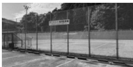
全面張り替えしたテニスコート
