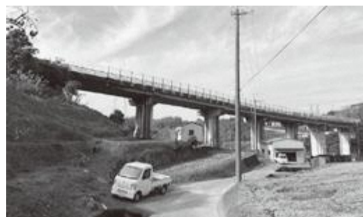
町道老朽化対策事業（鹿向谷大橋）
