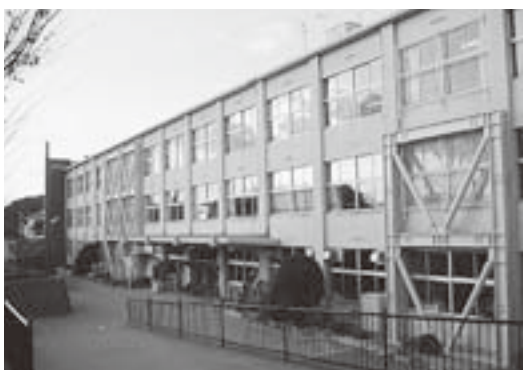
▲耐震工事後の町立中学校舎
