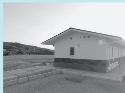
竣工した二子塚古墳の管理棟
