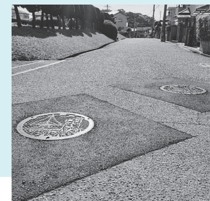
磯長台のマンホール蓋交換
