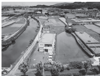
板屋橋浄水場
