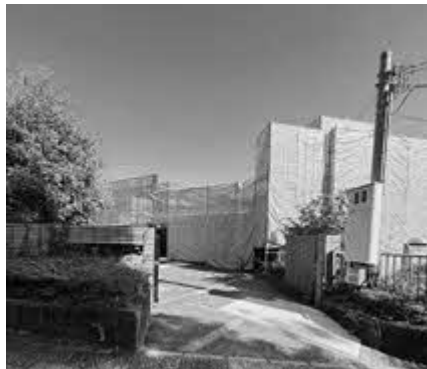
改修中の竹内街道歴史資料館
